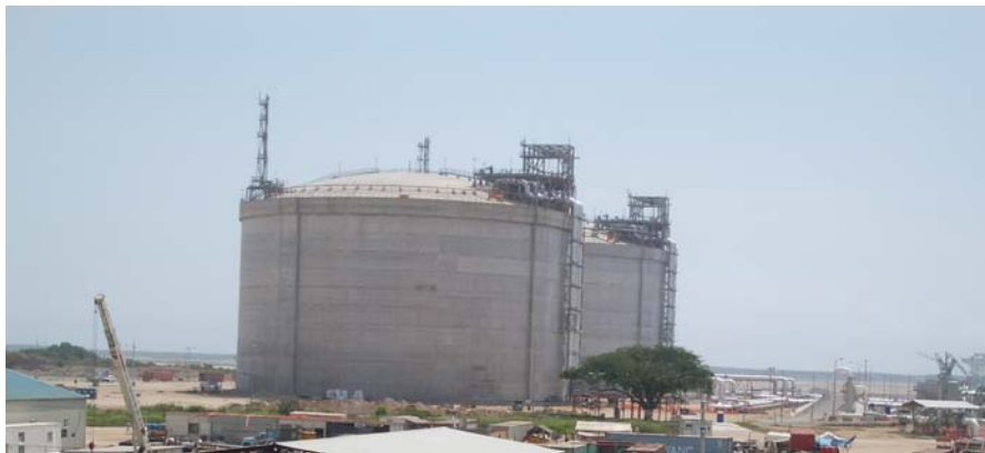
Fig. 11: Primeros tanques de almacenamiento de GNL en México - Terminal de LNG de Altamira, S. de R.L. de C.V.
