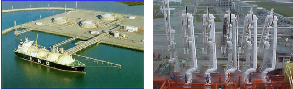
Fig. 6 Buque amarrado a muelle y brazos de descarga
