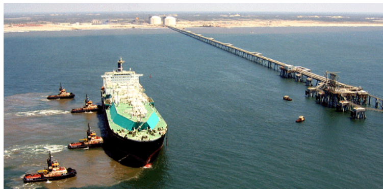
Fig. 5: Maniobra de aproximación al muelle de descarga
