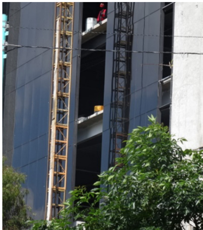
Colocación de acabados en la parte frontal del predio.
