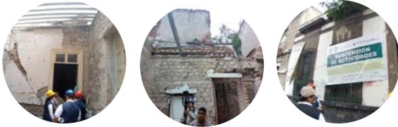
Magnolia 162 , departamentos 1, 2, 5 y 6, Guerrero, Cuauhtémoc: suspensión de actividades de retiro de acabados, modificación arquitectónica y reforzamiento estructural en inmueble catalogado.
