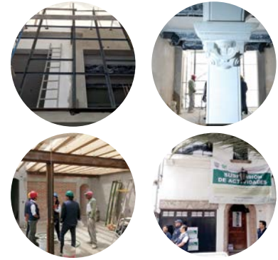
Yautepec 107 , Condesa, Cuauhtémoc: suspensión de actividades de demolición parcial, instalación de estructuras metálicas, escalera y pergolados en inmueble catalogado.
