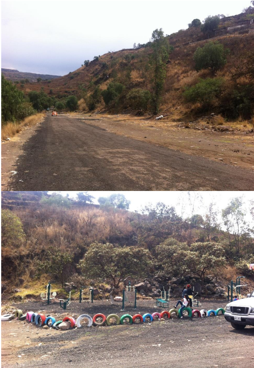
Figura 8.- Fotografías del tramo de camino de terracería, en la cual se observa el tipo de material colocado en el suelo, el cual al no cumplir con todo el proceso de pavimentación se considera semipermeable.
