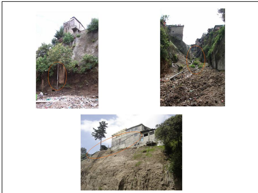
Figura. 3 Vertederos de aguas residuales
