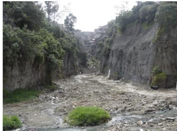
Después de las labores de limpieza 7 de Octubre 2008
