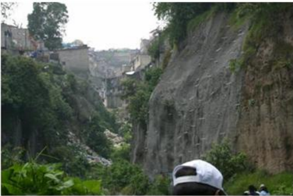
Antes de la limpieza de la barranca 2 Septiembre 2008
