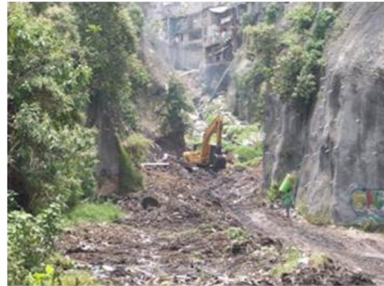
Durante las labores de limpieza 20 Septiembre 2008
