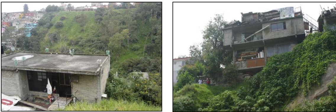
Figura 5.- Viviendas Ubicadas cerca de la barranca
