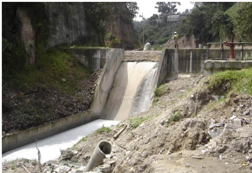
Figura 10.- Avances en los trabajos de limpieza de la presa tecolote
