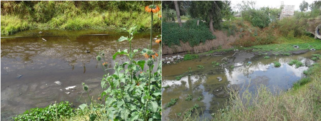
Figura 35.- Se muestra la zona poco profunda del canal donde se aprecia la acumulación de sedimentos y residuos.
