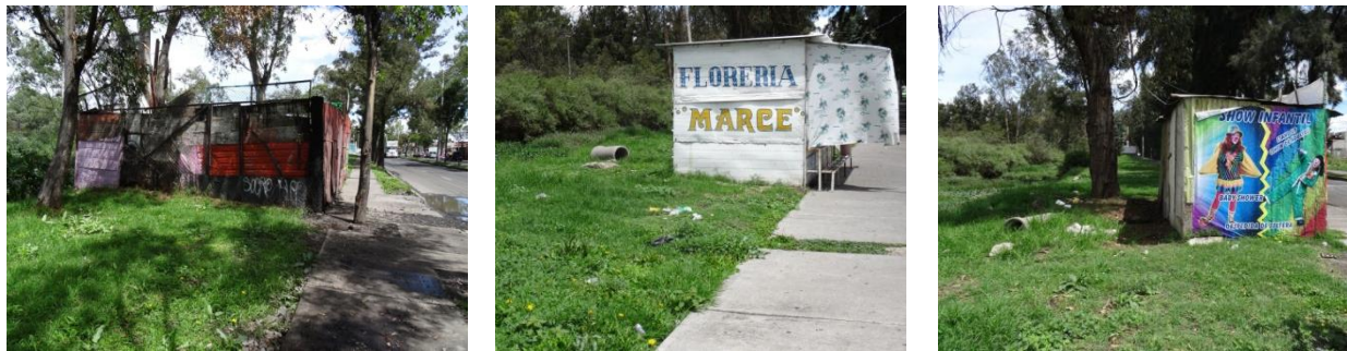
Figura 31.- Se observa la barda con la que cuenta una parte de este tramo, así como la vegetación acuática del canal.
